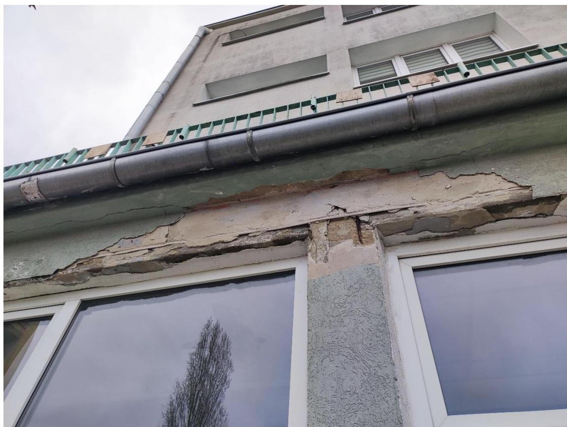
Fot. 5 Stan elewacji zewnętrznej, bezpośrednio poniżej omawianego tarasu.
